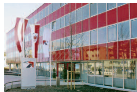
Gebäude des ARZ in Innsbruck.
